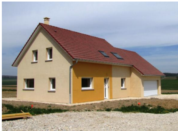
La maison terminée et labellisée BBC
